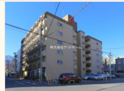
現況:外観 ('23/02/22撮影)
