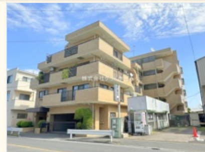
現況:外観 ('24/09/17撮影)
