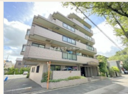
現況:外観 ('24/08/27撮影)
