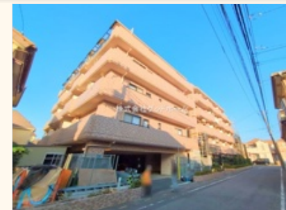
現況:外観 ('24/12/05撮影)
