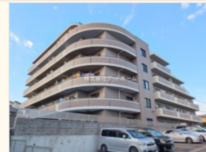
現況:外観 ('25/01/08撮影)
